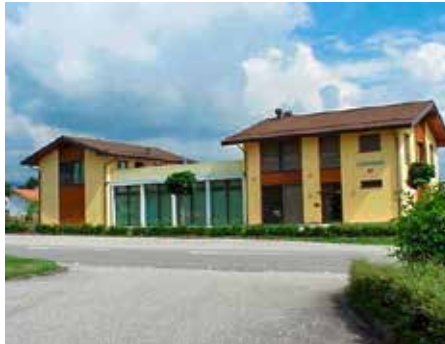
Il a fallu cinq tours pour pourvoir les cinq sièges de Sévery (VD).
